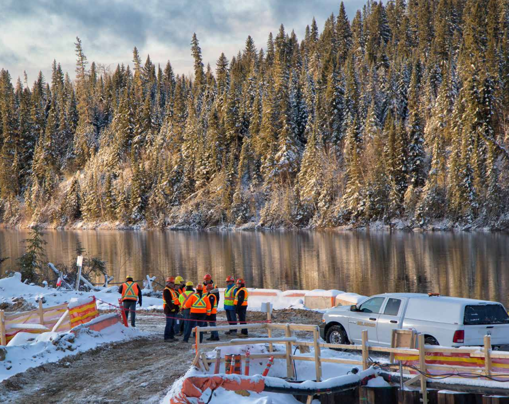
Chantier de la centrale Peter Sutherland Sr.
